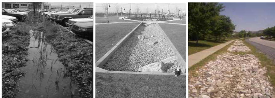
Figura 28 – Esempi di trincee d’infiltrazione
