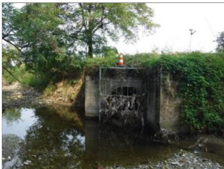
Figura 27 - Scaricatore di piena (nodo 1132) nel Torrente Molgora delle acque sfiorate al nodo 1126
