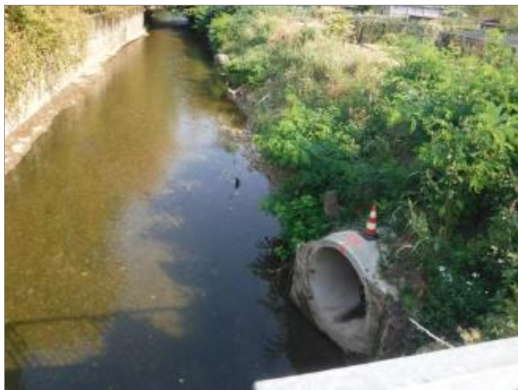
Figura 26 - Scaricatore di piena (nodo 915) nel Torrente Molgora delle acque sfiorate al nodo 913
