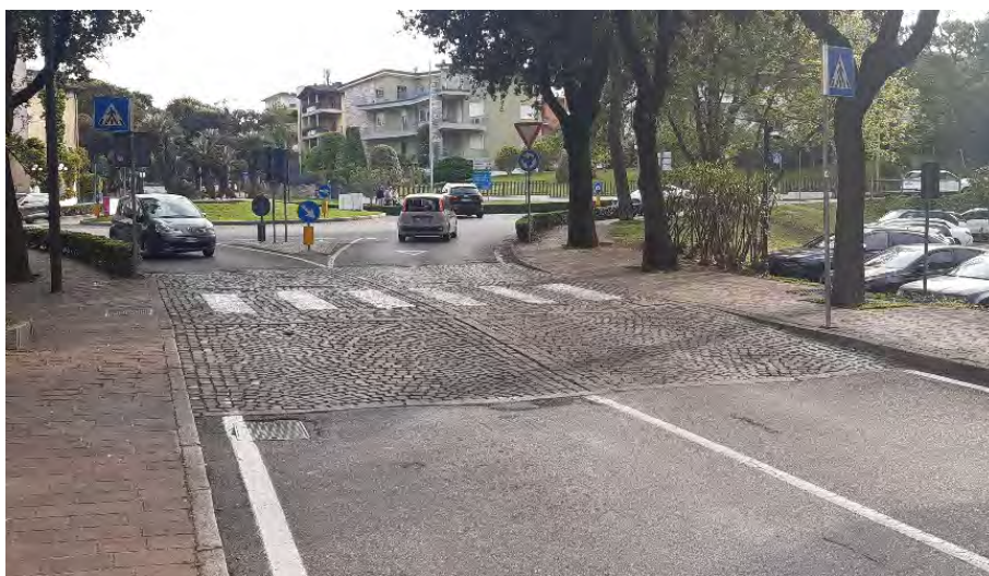
esempio di attraversamento pedonale rialzato
