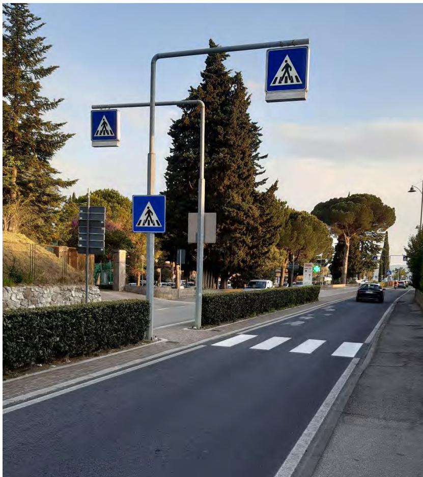
esempio di attraversamento pedonale protetto
