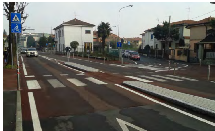
esempio di attraversamento ciclo-pedonale rialzato
