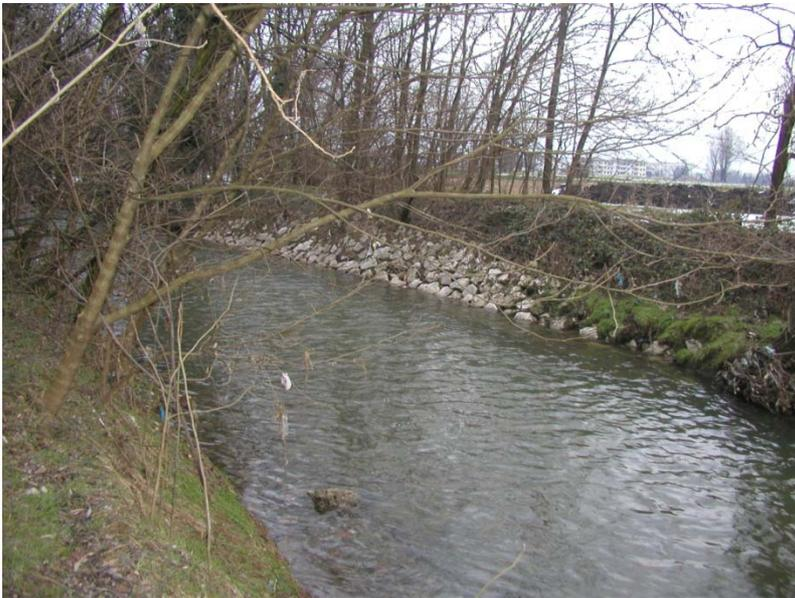
Fig.3.8 Argini in blocchi nel tratto 1 del torrente
