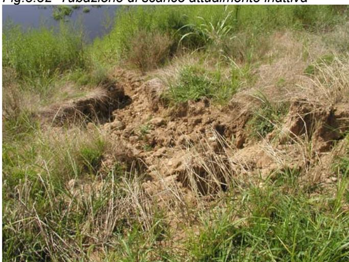
*Fig.3.33 Erosioni a fossi sulle sponde della vasca*
