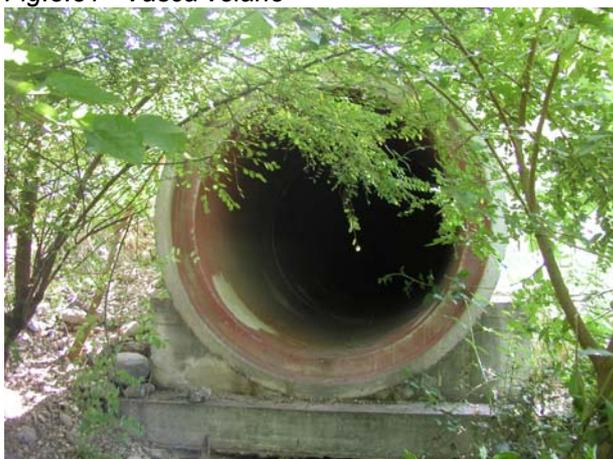
*Fig.3.32 Tubazione di scarico attualmente inattiva*
