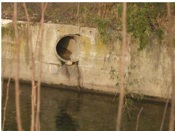
Fig.3.12 Scarico fognario di piena in sponda sn a valle di via Buozzi
