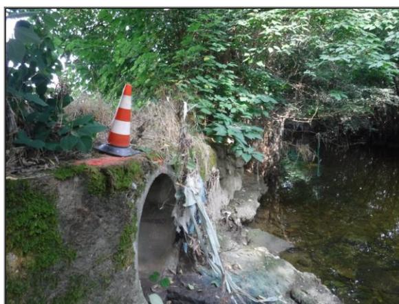
Figura 29 – Scaricatore di piena (nodo 1089) nel Torrente Molgora delle acque sfiorate al nodo 1085
