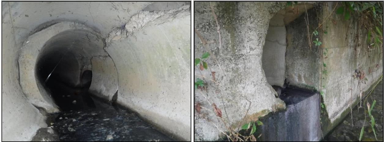
**Figura 33 - Scaricatore di piena nodo 1050 nel Torrente Molgora di parte delle acque sfiorate al nodo 1091**
