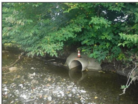
Figura 26 - Scaricatore di piena (nodo 1194) nel Torrente Molgora delle acque sfiorate al nodo 1062
