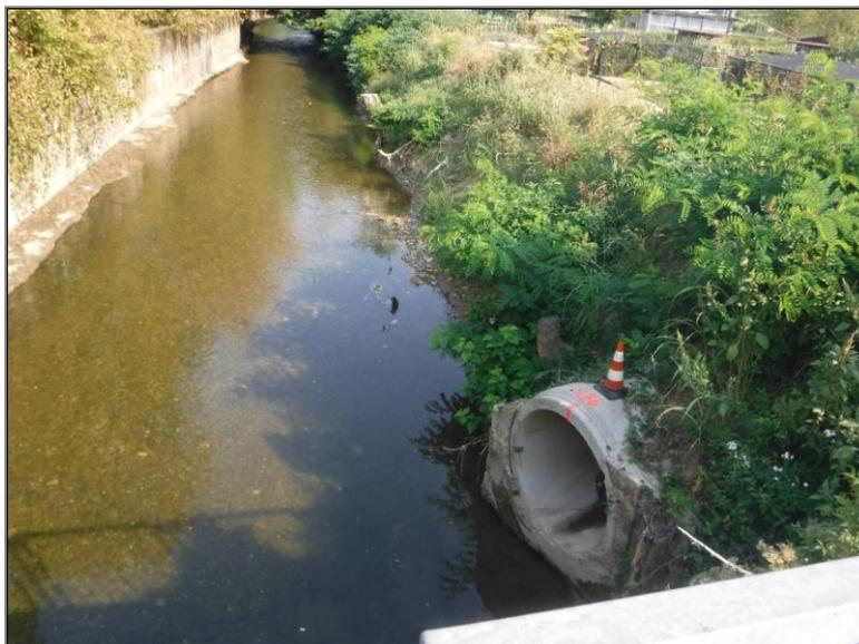
**Figura 23 - Scaricatore di piena (nodo 915) nel Torrente Molgora delle acque sfiorate al nodo 913**
