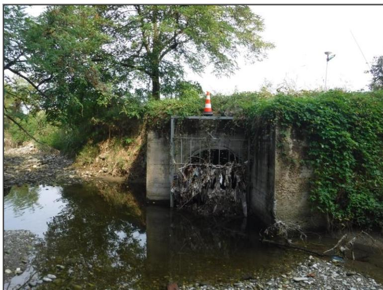
Figura 36 - Scaricatore di piena (nodo 1132) nel Torrente Molgora delle acque sfiorate al nodo 1126
