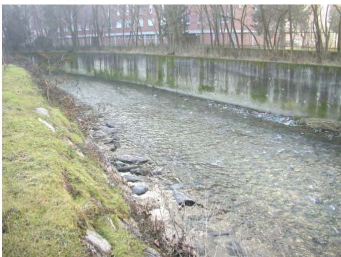
Fig.3.15 Sponde in massiciata (sn) e in muro cls (dx) a monte di via Mattei
