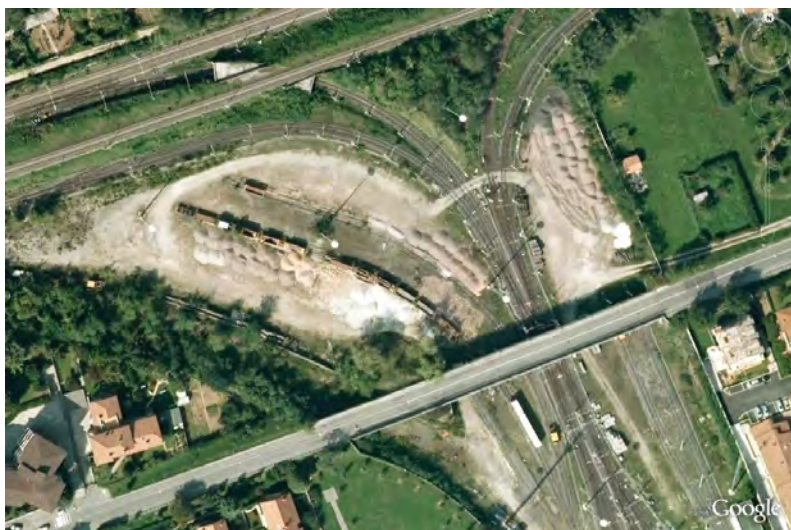
Fig. 5.25 Area in trasformazione/movimento dei depositi della Linea Metropolitana
