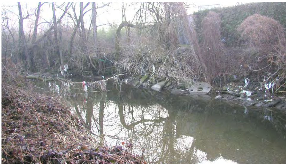
Fig.3.17 Tratto con sponde degradate tra via Mattei e la Martesana
