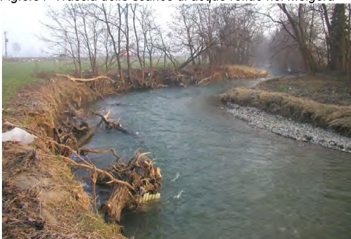
Fig.3.35 Anse dell'alveo nel tratto sud, oltre il confine comunale
