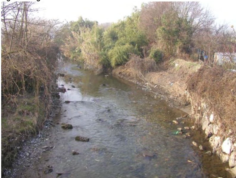
Fig.3.9 Tratto subito a monte di via Buozzi
