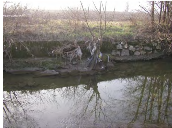
Fig.3.13 Scarico attivo (?) a monte della linea metropolitana
