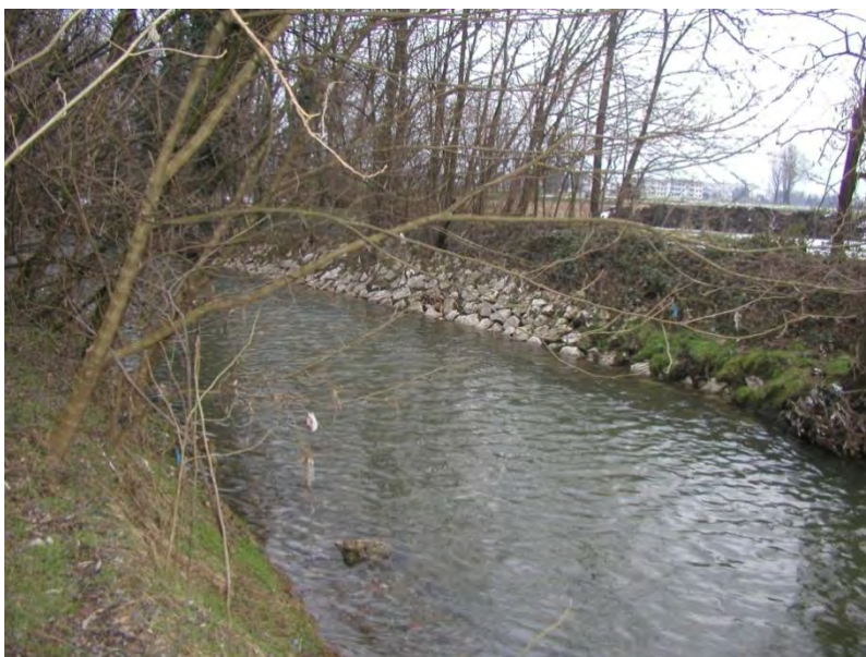
Fig.3.8 Argini in blocchi nel tratto 1 del torrente
