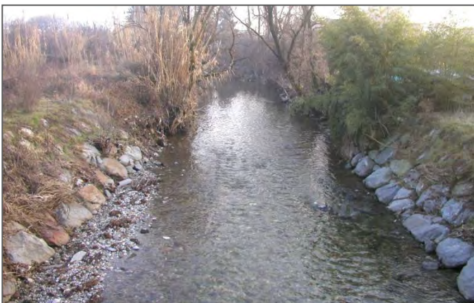
Fig.3.16 Tratto subito a valle di via Mattei
